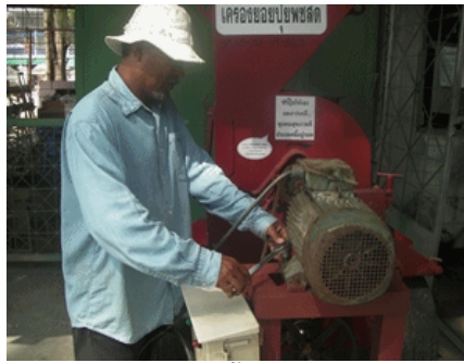
ภาพที่ 9 ติดตั้งแท่นมอเตอร์
