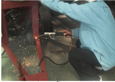
ภาพที่ 8 ติดตั้งแท่นมอเตอร์
