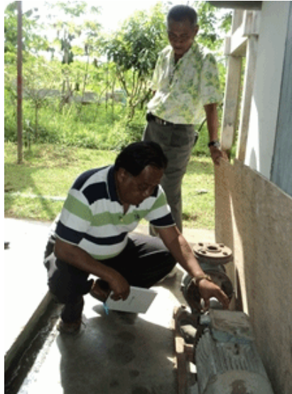
ภาพที่ 3 ตรวจสอบสภาพมอเตอร์
